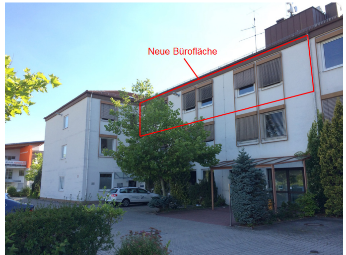
Neue Bürofläche im Mittelbau im 2. OG des Bürogebäudes „Am Weichselgarten 9“
